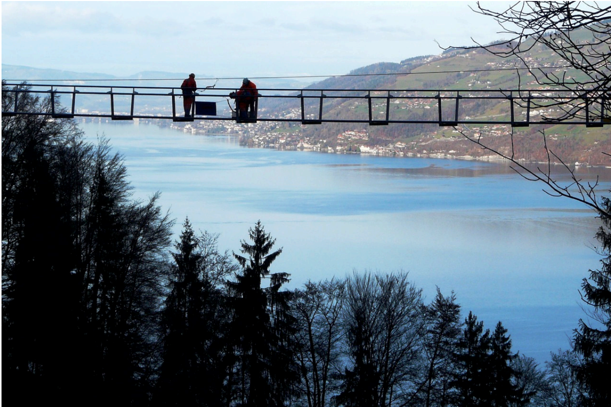
Leissigen, 08.12.2011 / Brückenmontage Seiler AG
